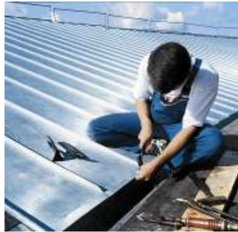
Bei der Auflösung des Investitionsstaus sollen insbesondere die heimischen Firmen zum Zuge kommen, so Thauer.
